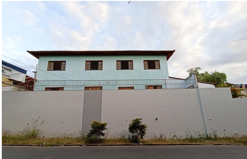
Figura 10: Fachada frontal do abrigo Casa de Apoio.
