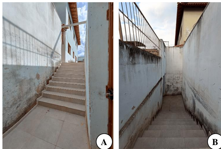
Figura 12: Escada de acesso do Centro de Apoio Social Aliança vista de baixo (A) e vista de cima (B).
