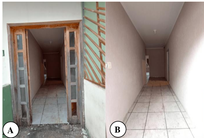
Figura 32: Hall de entrada, circulação interna 1º pavimento
