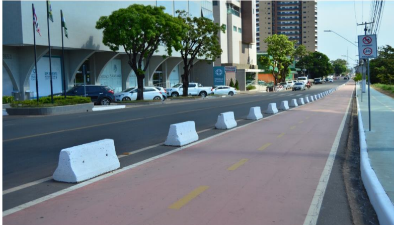
Imagem 19: Ciclovia paralela a pista de rolamento.
